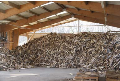
Stock de bûche sous le hangar à ossature bois
